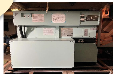
入替完了後（型式：40馬力の「デッキユニット」）
